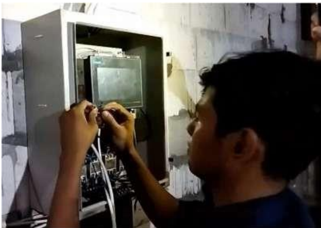
Gambar 7. Pemasangan dan pengawatan rangkaian kontrol HMI di kotak panel
