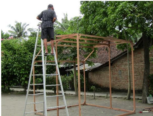
Gambar 6. Proses pengerjaan kerangka modul aquaponic (dokumentasi tim, 2021)
