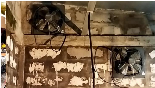
Gambar 6. Pemasangan Exhaust Fan untuk membuang udara panas ke luar ruang pemanas
