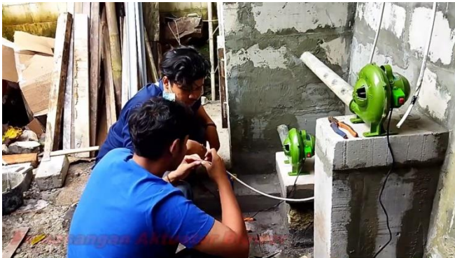
Gambar 5. Pemasangan dan pengawatan Blower untuk menghembuskan udara panas ke ruang pemanas
