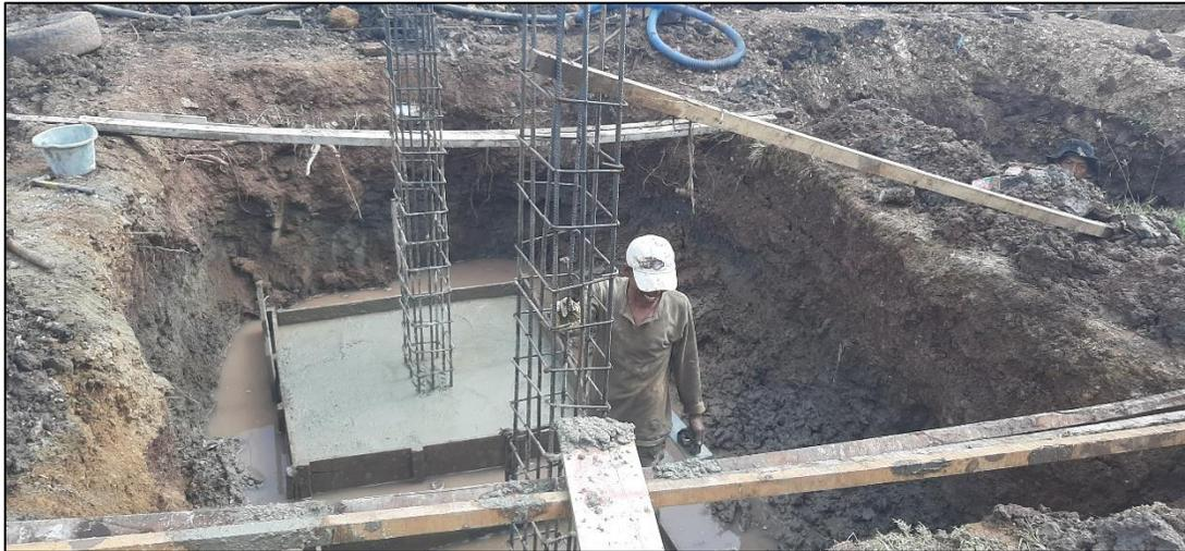
**Gambar 4.** Hasil Pengecoran Fondasi
