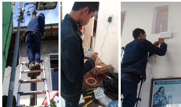
Gambar 4. Pemasangan Jaringan Internet IndiHome
