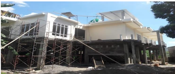
Gambar 1. Kondisi Masjid dari depan saat proses renovasi
