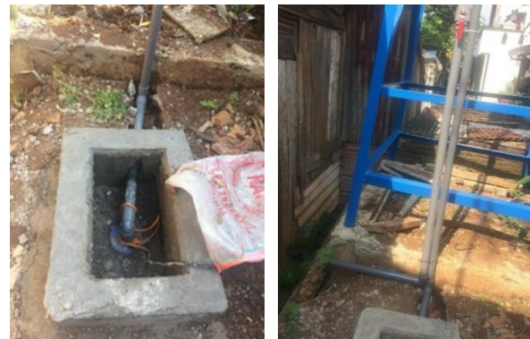
Gambar 3. Pemasangan Jaringan Pipa Utama
