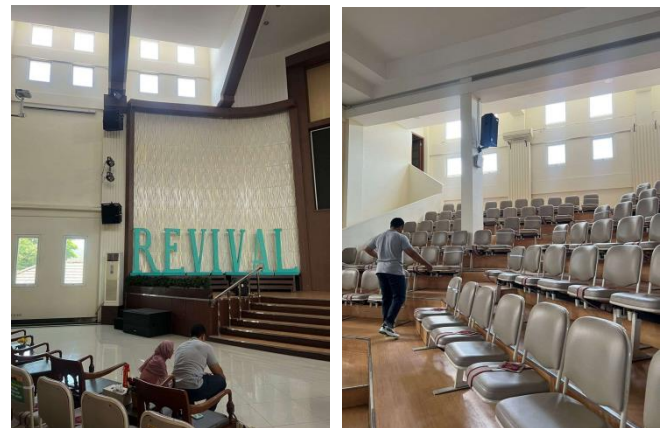
Gambar 3. Dinding ruangan yang telah menggunakan material akustik diffuser (kiri-kanan podium dan kolom bangunan)
