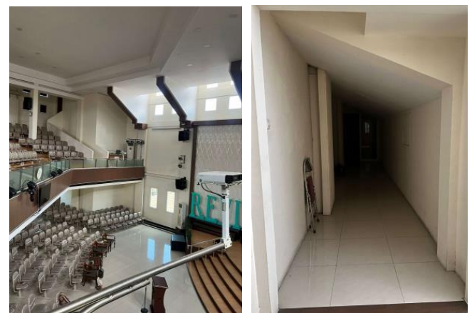
Gambar 4. Plafon dan dinding sejajar yang (kiri) yang berpotensi flutter echo. Permukaan ruang yang dominan datar (kiri). Lorong belakang balkon (kanan) yang berpotensi menghasilkan late reverberation.
