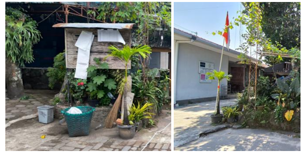
Gambar 13 Eksisting Area Signage (Dokumentasi Penulis, 2024)
