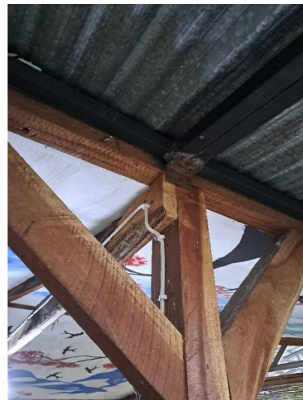
Gambar 5. Material atap penghantar panas
