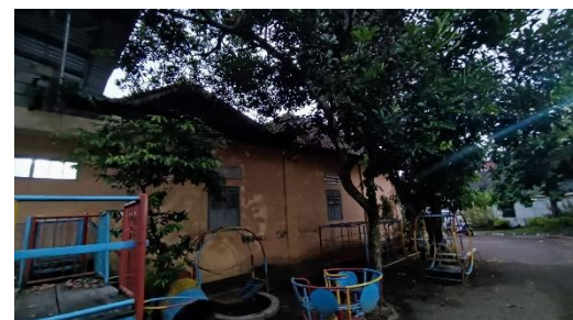
Gambar 3. Survey Kondisi Terkini
