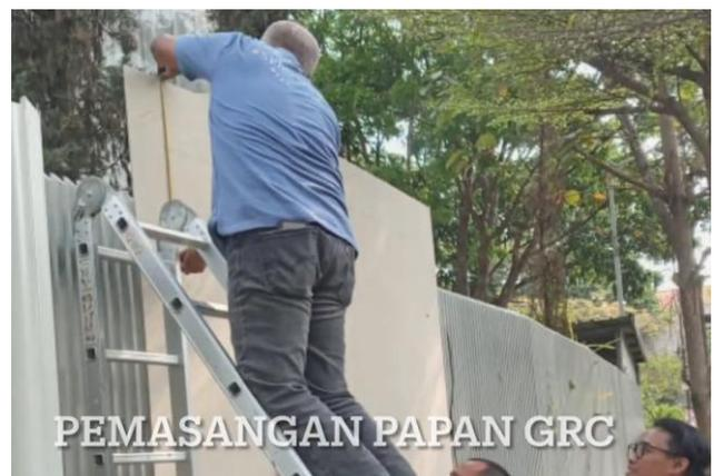
Gambar 3. Pemasangan GRC, Romo Tribowo melakukan pengukuran
