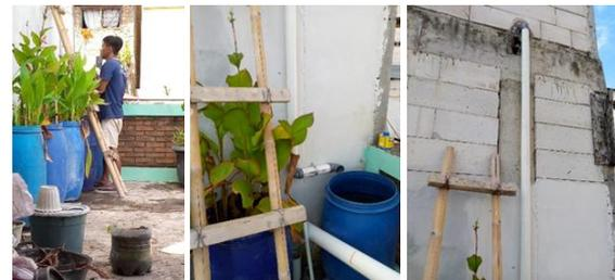
Gambar 18. 10 Februari 2024, warga secara mandiri memasang pipa dari lokasi mesin cuci kepada drum
