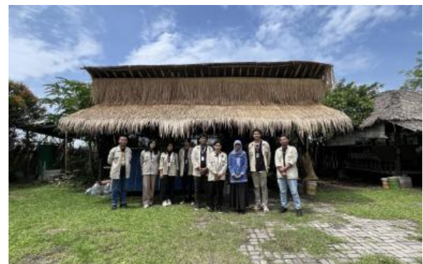
Gambar 13. Kondisi Akhir Balai Bambu Pasca Rehabilitasi (Dokumentasi Komunitas Kagem, 2025)
