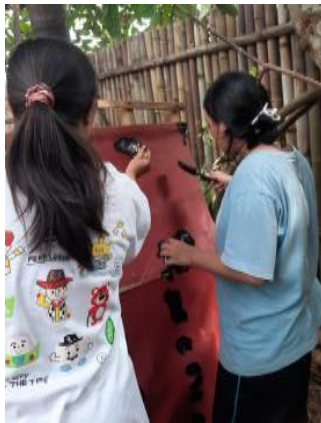
Gambar 11. Pemberian Lapisan Anti Bocor pada Atap (Dokumentasi tim panitia, 2025)
