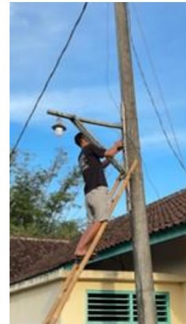
Gambar 1. Pemasangan Instalasi Listrik ke Tiang Lampu
