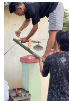
Gambar 2. Pemasangan Lampu Ke Tiang Listrik
