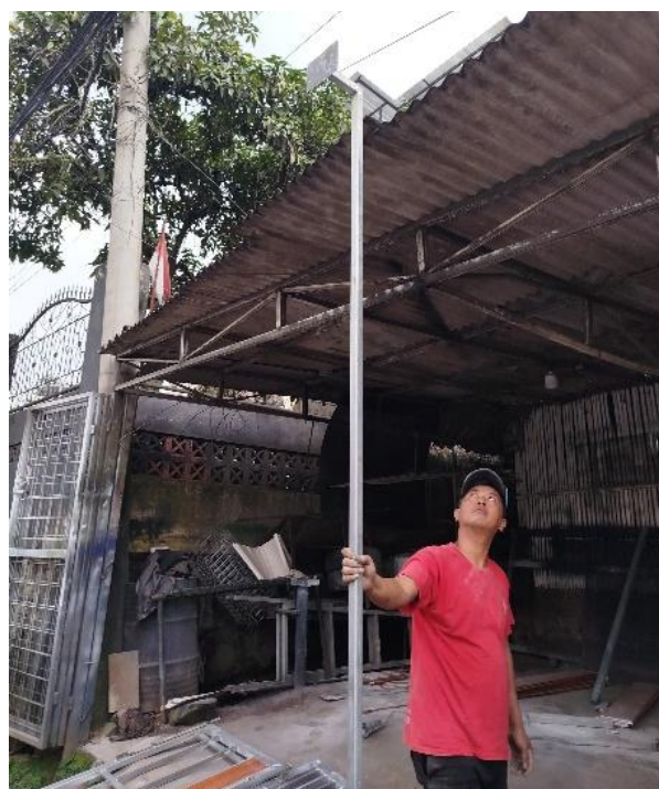
Gambar 3. Pembuatan Tiang Lampu Penerangan Jalan
