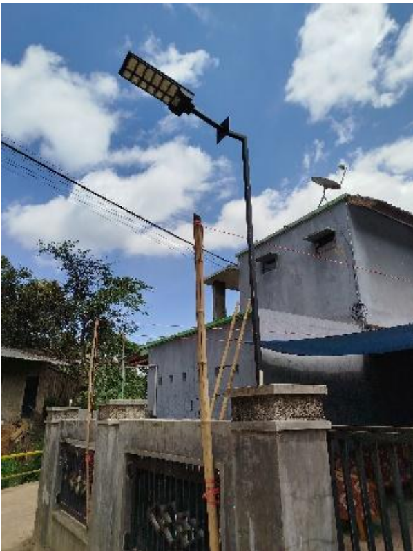
Gambar 5. Hasil pemasangan lampu penerangan jalan bertenaga surya (tampak depan)
