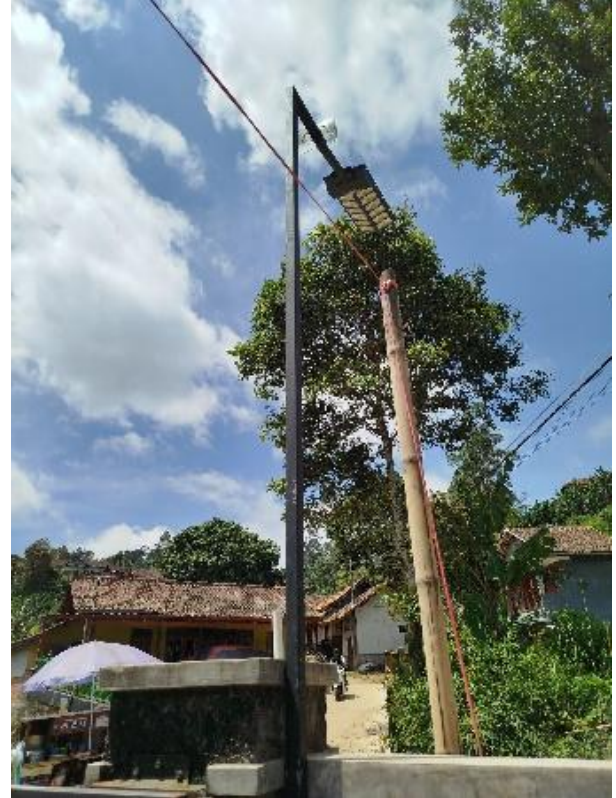
Gambar 6. Hasil pemasangan lampu penerangan jalan bertenaga surya (tampak belakang)
