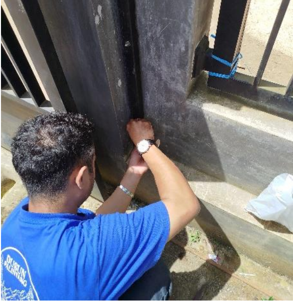
Gambar 4. Proses Pemasangan Lampu Penerangan Jalan
