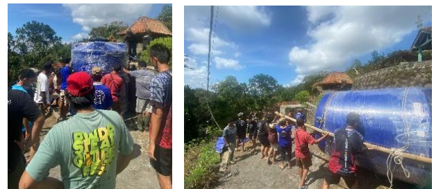
Gambar 1. Pemasangan Tangki Air untuk Pengadaan Air di Dusun Kapuhan
