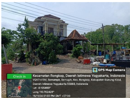
Gambar 5. Rumah Permanen di Desa Semugih Kecamatan Rongkop.
