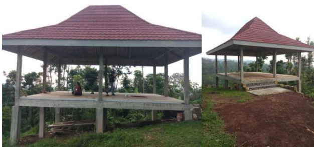
Gambar 1. Kondisi Awal Galeri Kerukunan Umat Beragama Sebelum Pemasangan Fasad
