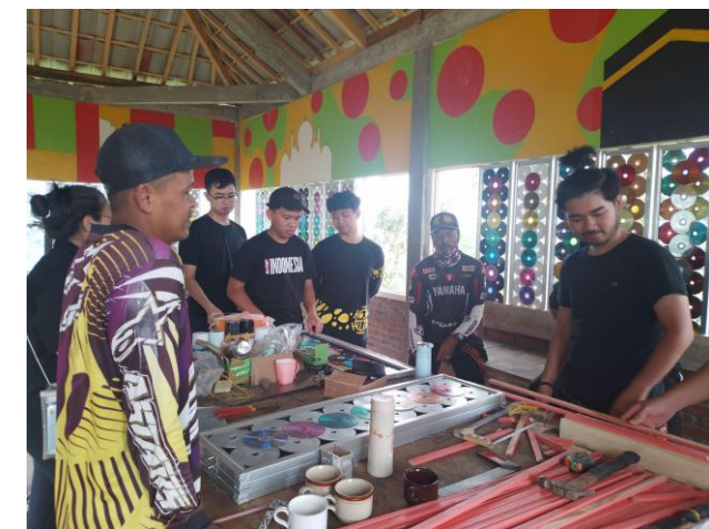
Gambar 4. Proses Pemasangan Panel pada Galeri Kerukunan
