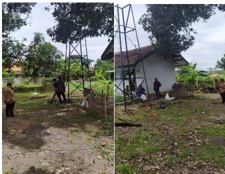
Gambar 2 Pemasangan Tandin Air
