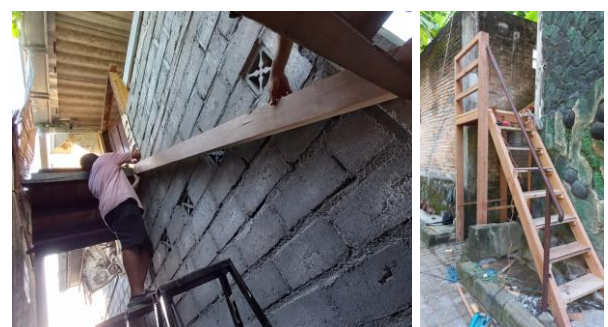
Gambar 8. Pemasangan tangga renovasi
