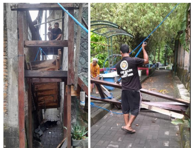
Gambar 7. Pembongkaran tangga eksisting
