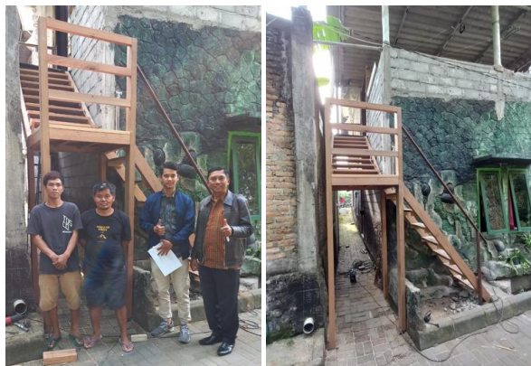
Gambar 10. Foto tim pengabdian dan hasil akhir pekerjaan renovasi tangga kayu
