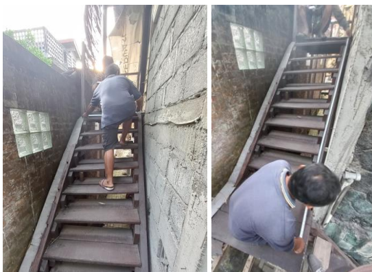
Gambar 5. Pengukuran kebutuhan kayu renovasi
