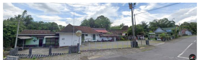
Gambar 1. Kondisi Eksisting Pastoran Somohitan (Sumber: Google Map, 2024)
