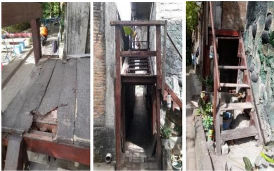
Gambar 1. Kondisi bangunan pertemuan warga dari konstruksi kayu (sumber: dokumentasi warga)
