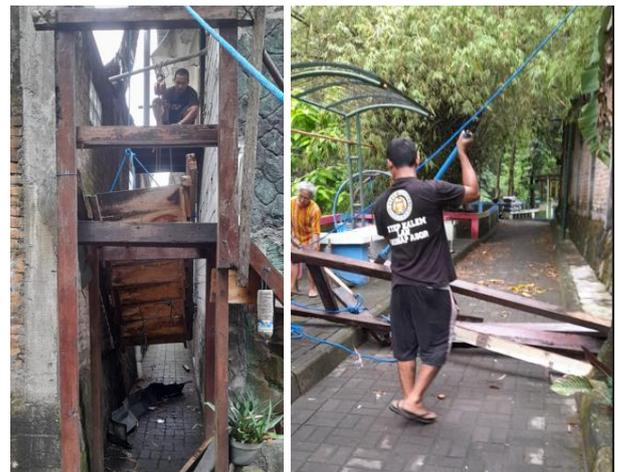
Gambar 7. Pembongkaran tangga eksisting
