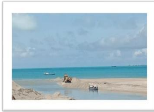
Gambar 1. Kondisi Muara dan Aktivitas Pendalaman serta Penggalian agar Tidak Terjadi Pendangkalan sehingga Perahu dapat Melintas
