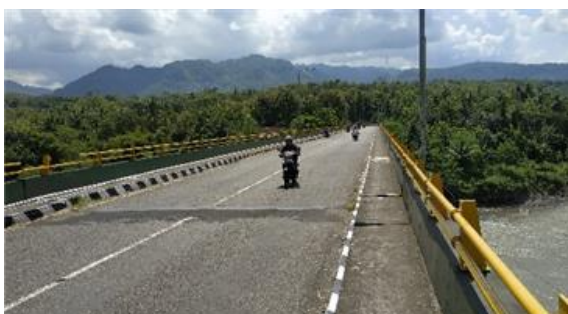
Gambar 10. Jembatan beton Kreo (Kebun Agung II)
