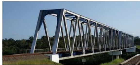
Gambar 11. Jembatan baja KA Mbeling II
