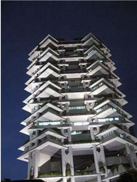
Gambar 1. Gedung Wisma Dharmala yang menggunakan penyelesaian atap teras untuk memberi tanggapan pada iklim tropis Sumber: www.septanabp.wordpress.com , diunduh tanggal 9 September 2012
