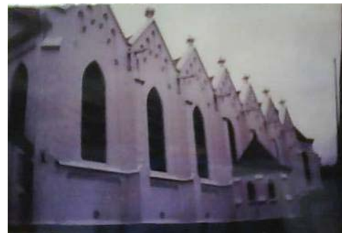
Gambar 5. Bentuk flying buttress sebagai aksen di antara deretan jendela kaca patri berbentuk pointed arch
