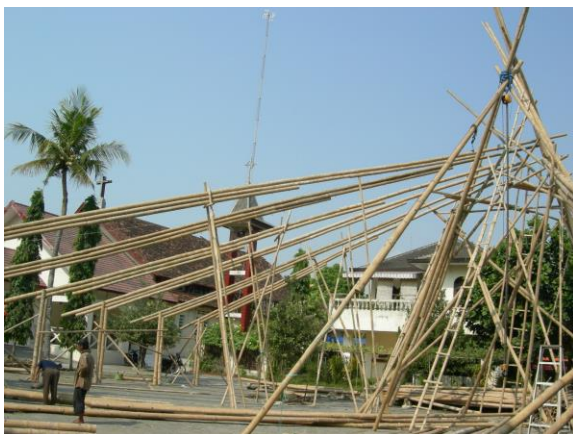
Gambar 5: Model Bentangan lebar 16-18 m Sumber: Dokumen Pribadi 30/8/2006
