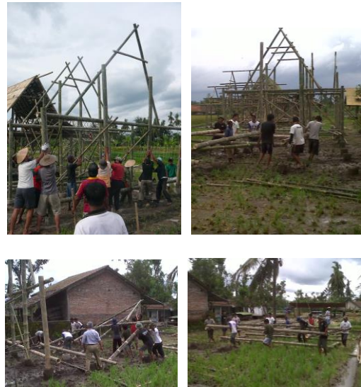
Gambar 3: Proses Angkut dan Perangkaian Secara Gotong Royong Sumber: Dokumen pribadi 4/2/2011
