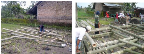
Gambar 2: Pembuatan Konstruksi Modular Sumber: Dokumen Pribadi 30/1/2011 & 4/2/2011
