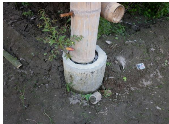
Gambar 10. Umpak Berongga pada Huntara Sumber: Dokumen Pribadi 19/4/2011
