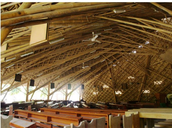
Gambar 8: Gereja Bambu St. Yakobus Ruang umat bebas kolom di tengah Sumber: Dokumen Pribadi 31/10/2007
