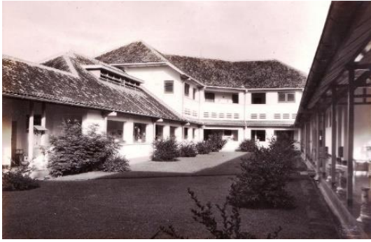
Gambar 1. Tampak asli kompleks RSM Undaan sebelum renovasi (Sumber: Arsip yayasan P4MU, 2019).
