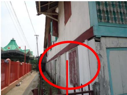
Dinding pada tampak samping bagian bawah berbeda-beda, ada yang menggunakan beton dan ada yang menggunakan kayu
