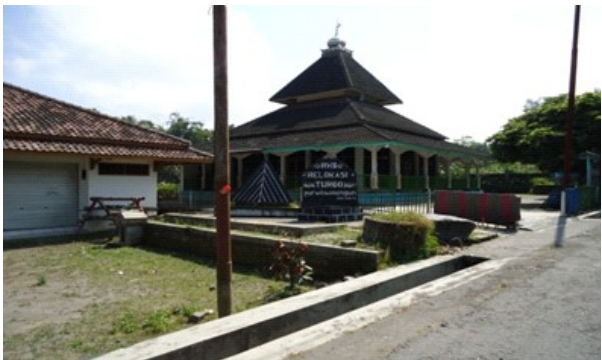
Gambar-6. Masjid di permukiman relokasi dusun Sudimoro (dok. Pribadi, Juni 2011)
