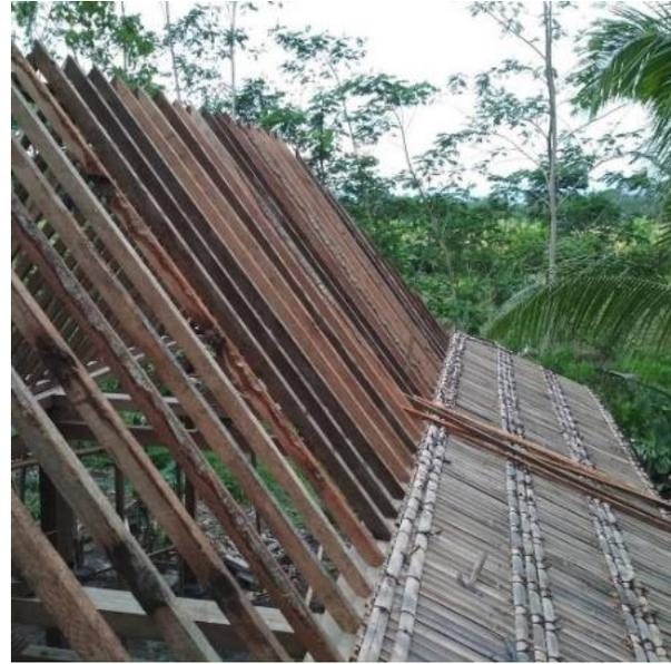
Gambar 8. Pemasangan *empyak* pada rumah tradisional Jawa, a. posisi *empyak raguman* dan *gaplokan* dalam struktur atap (sumber : [empyak deskgram.net](http://empyakdeskgram.net), 2018),
