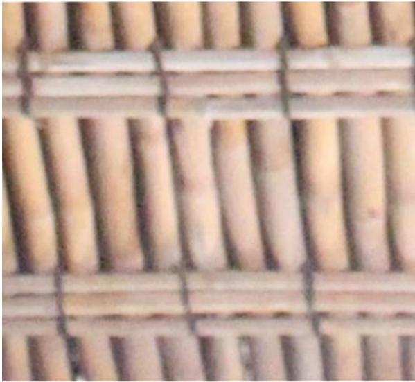
Gambar 4. Detail susunan bambu *empyak raguman* pada rumah tradisional Jawa (sumber : dokumentasi penulis, 2017)
