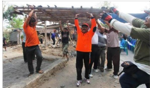
Gambar 10. Proses pemasangan *empyak* dengan gotong royong (sumber : *empyak on jumPic*, 2018)
