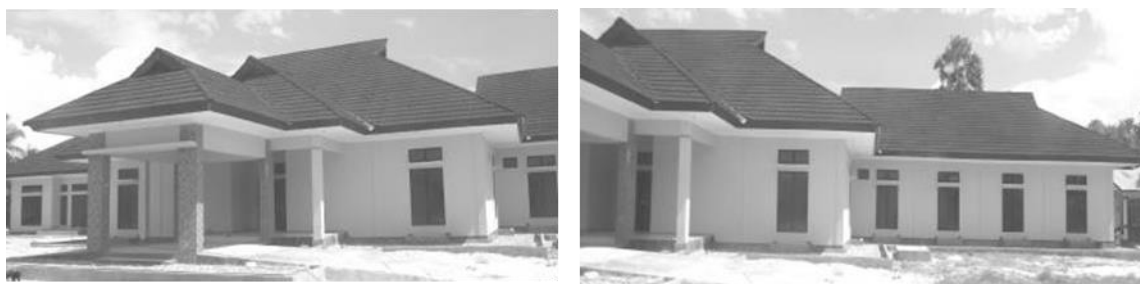
Gambar 19: Penginapan Pemda Sabu Raijua di Raijua (Sumber : Hasil Studi Lapangan 2015)
