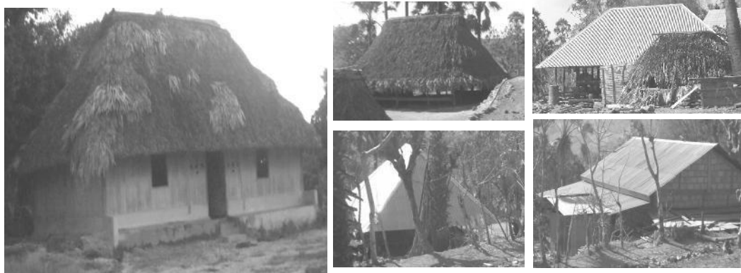
Gambar 12: Perubahan material dinding rumah di Lede Unu Raijua (Sumber : Hasil Studi Lapangan 2015)
