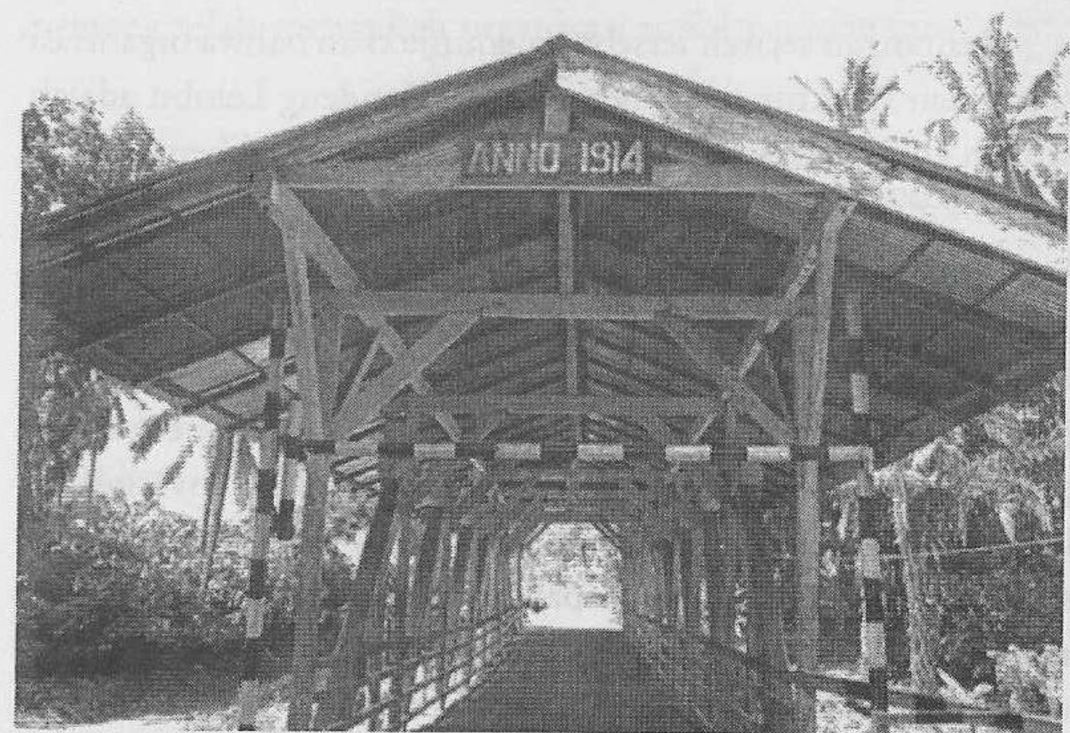
Foto 1. Jembatan Pintu Gerbang Komplek Perkebunan.
